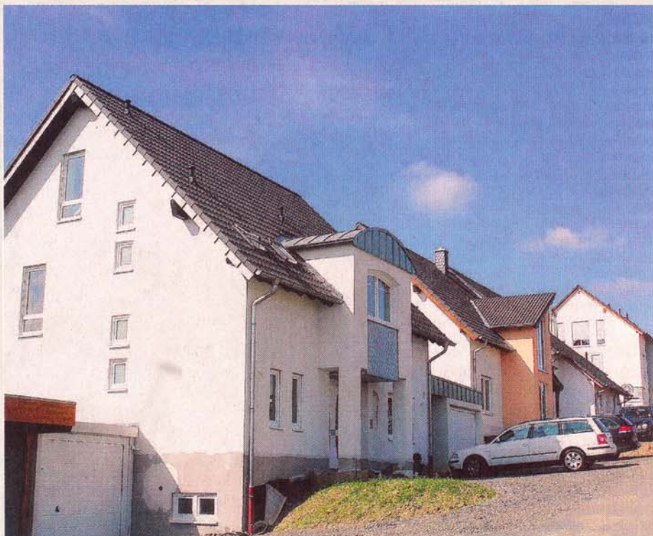
14 Häuser stehen inzwischen in Hilfringhausen. Insgesamt sollen 90 Eigenheime im Eifgenblick entstehen. Dass das kostengünstig geht, soll der Tag der offenen Tür Bauwilligen zeigen.
